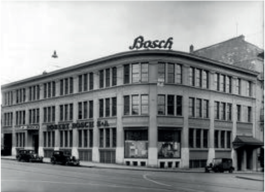
Figure 60. Usine Bosch construite en 1920 sur la rue de Lausanne
