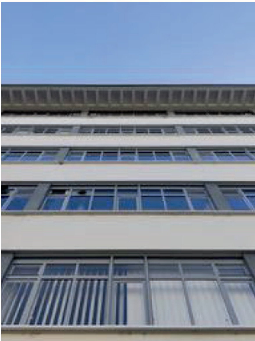
Figure 126. Les façades sont non-porteuses composées de bandeaux de fenêtres
