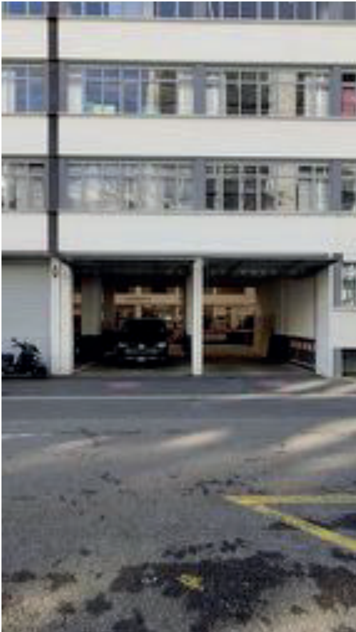
Figure 123. Un des accès latéraux à la cour pour les camions
