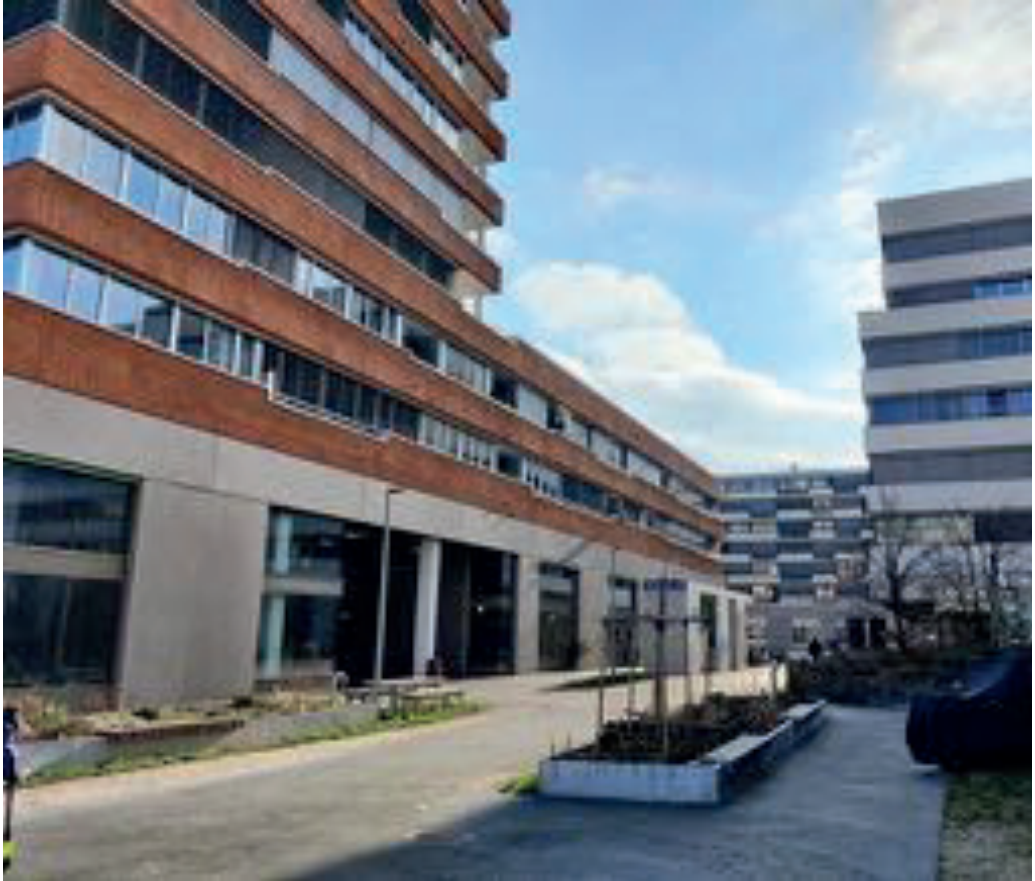
Figure 89. Vue des trois bâtiments qui compose l'écoquartier de la jonction
