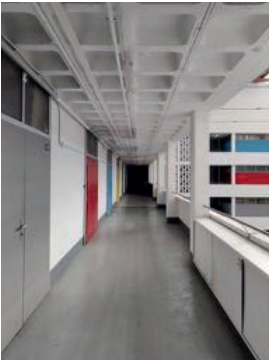
Figure 125. Le système de coursive qui distribue les ateliers autour de la cour centrale
