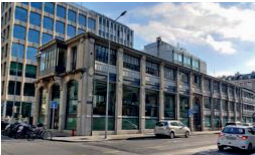
Figure 53. Ancienne usine Simba, 17 Rue de l'Arquebuse
