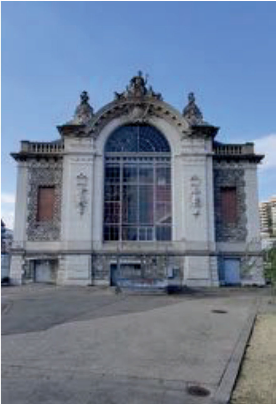
Figure 39. Pignon Est du BFM
