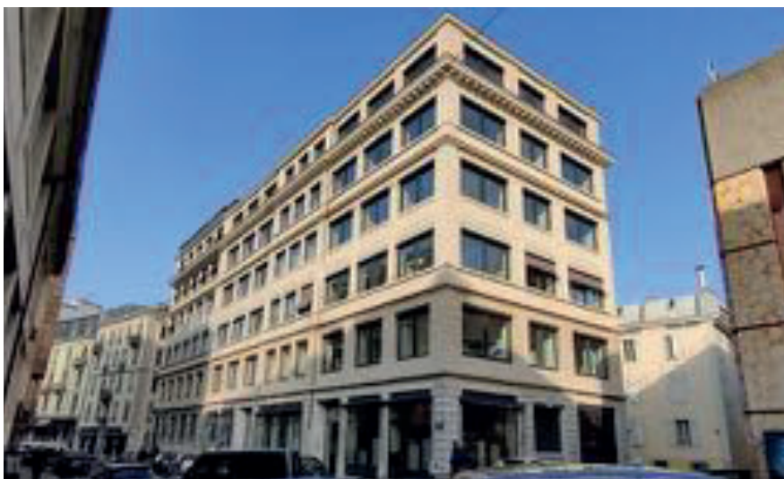
Figure 54. Ensemble manufacturier, 25 Rue de la Coulouvrenière
