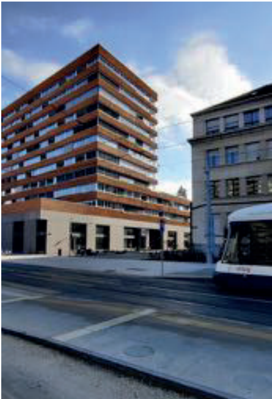
Figure 116. L'immeuble de la CODHA (gauche) et l'ancien édifice administratif des SIG (droite)
