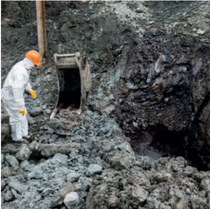
Figure 108. État du sol pendant l'assainissement de l'ancien site Artamis
