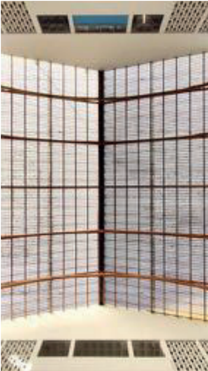
Figure 122. La verrière avec la charpente en bois
