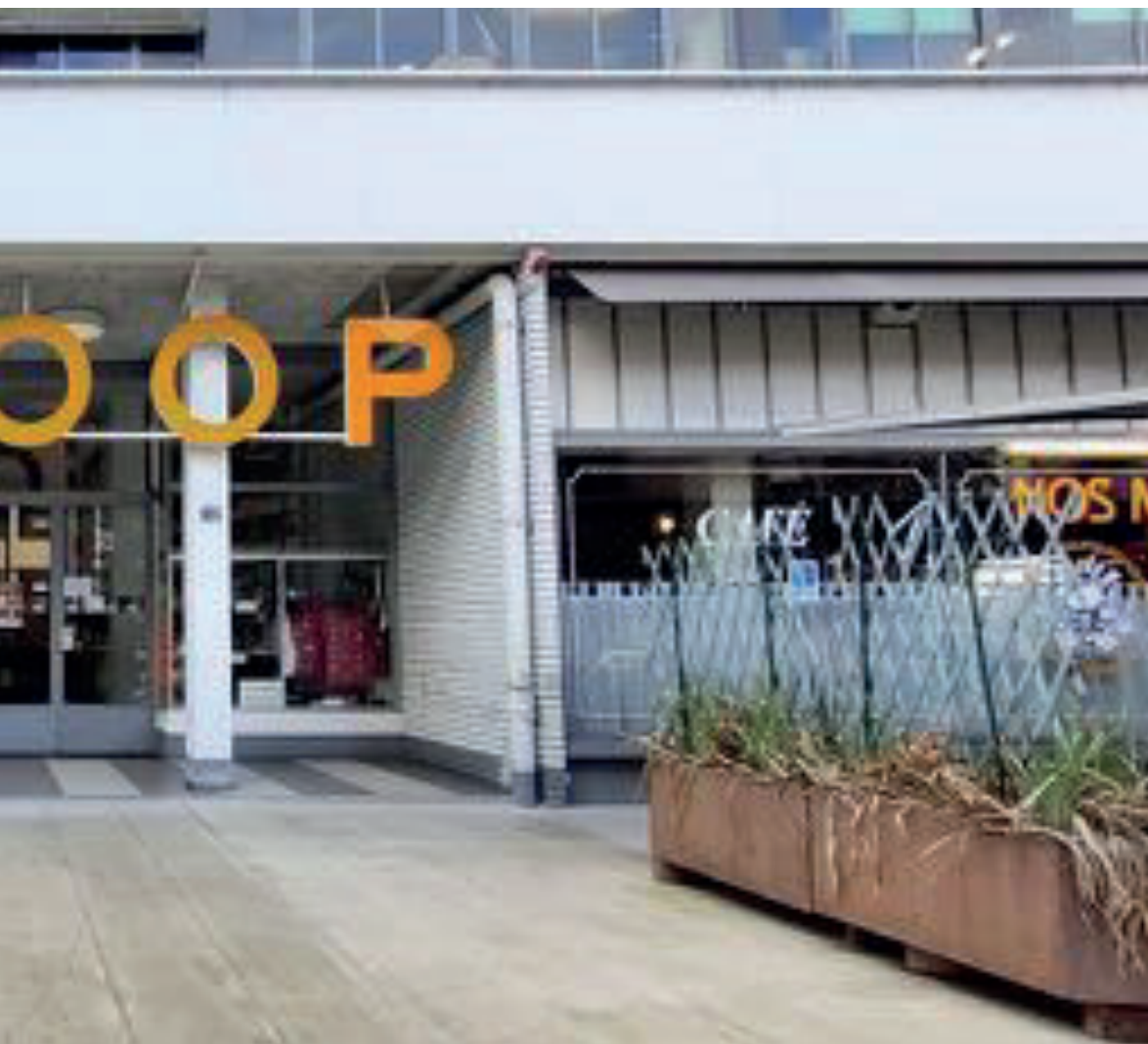
Figure 121. Entrée principale de ARCOOP qui conduit directement aux distributions verticales et à la cour centrale
