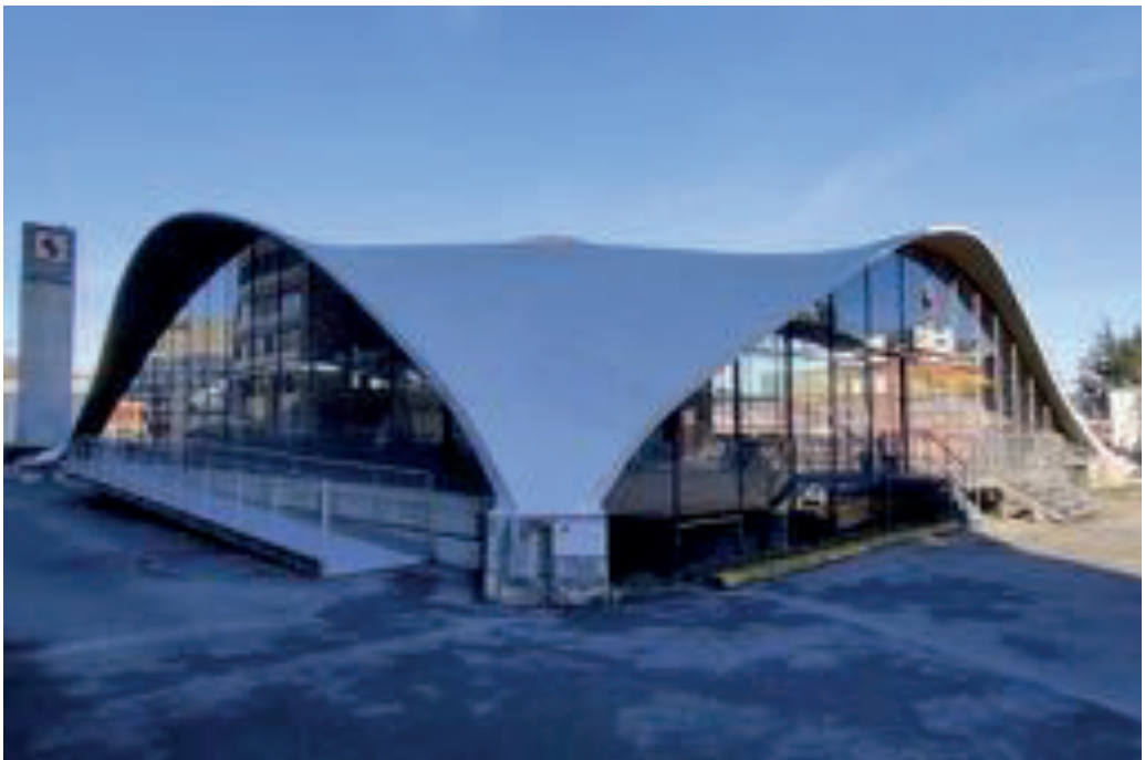
Figure 38. Un des points d'appui de la grande coque
