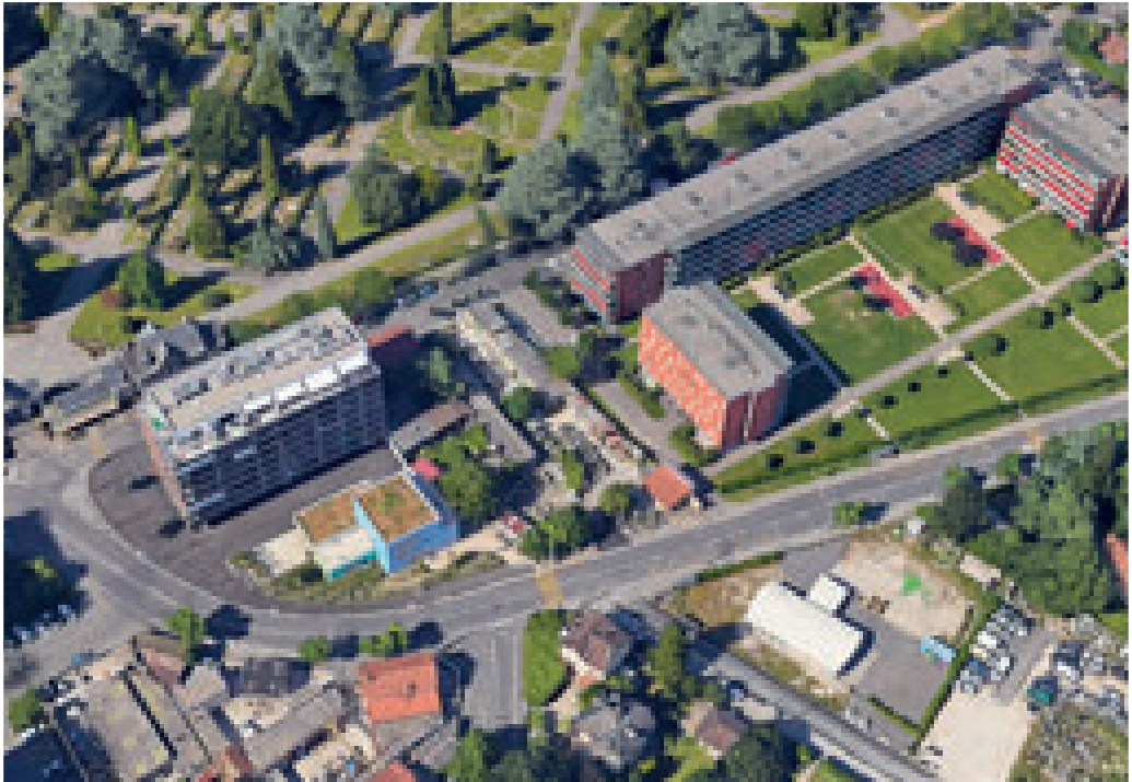
Figure 86. Orthophoto de l'atelier CAL'AS coincé entre deux parcelles de logements
