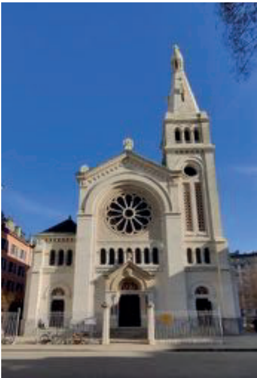
Figure 65. Façade de l'église Saint François de Sales restaurée
