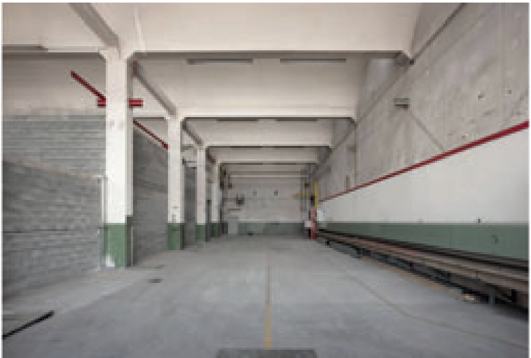
Figure 97. Ancien dépôt du SIS désaffecté, il va permettre d'accueillir de nouvelles activités au sein de la ZIC
