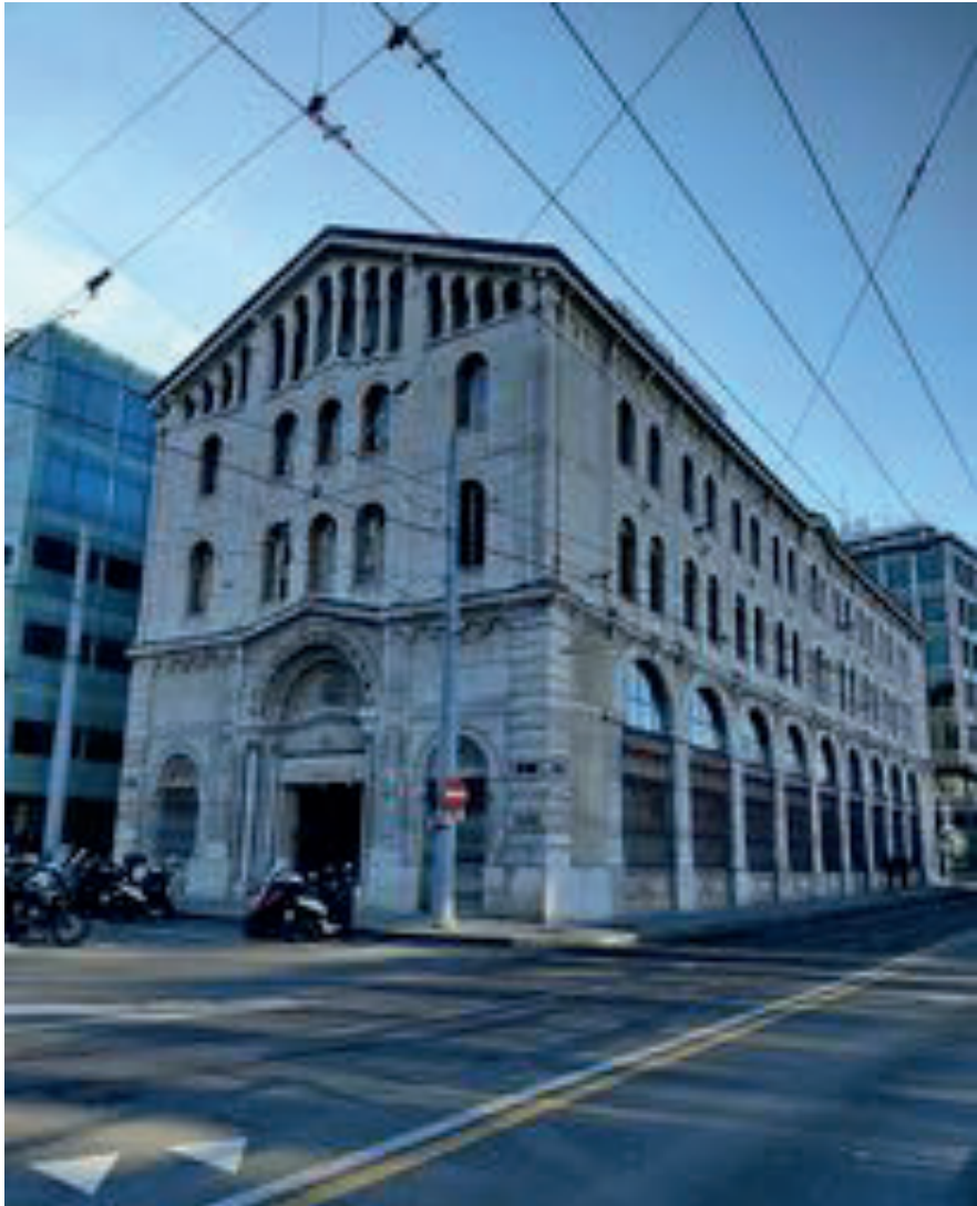
Figure 35. Ancienne halle de marché aillant subi une sur-élévation, près de la place Bel Air
