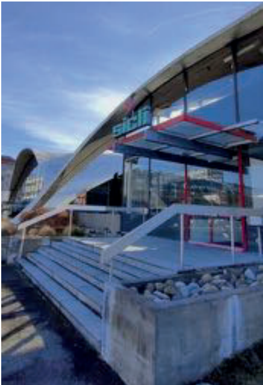
Figure 36. Entrée principale du bâtiment
