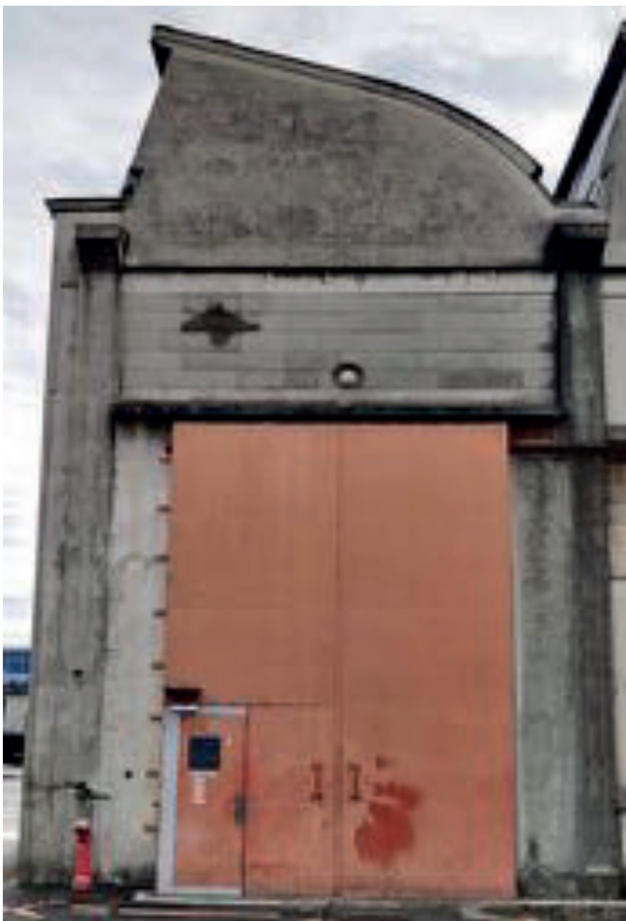
Figure 99. La plupart des bâtiments sont équipés de grandes portes d'accès
