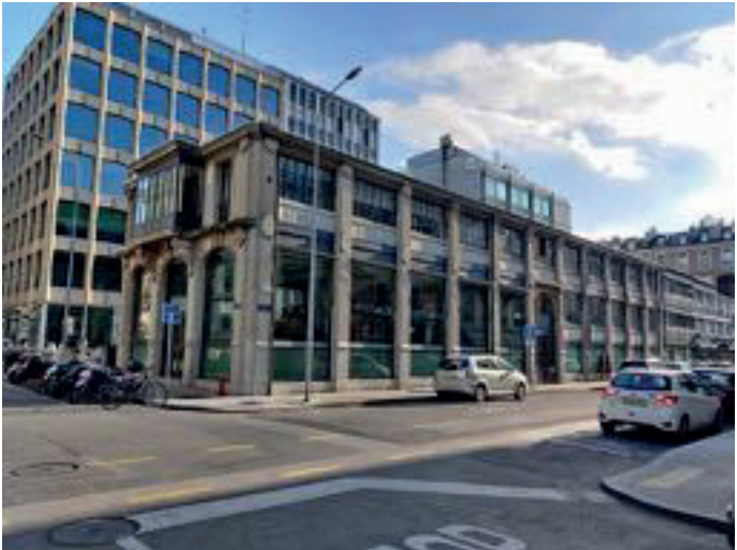
Figure 58. Ancienne usine Simba, 17 Rue de l' Arquebuse
