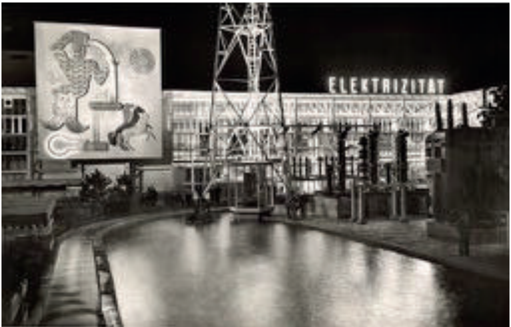
Figure 23. Pavillon électrique de l'exposition nationale suisse de 1939
