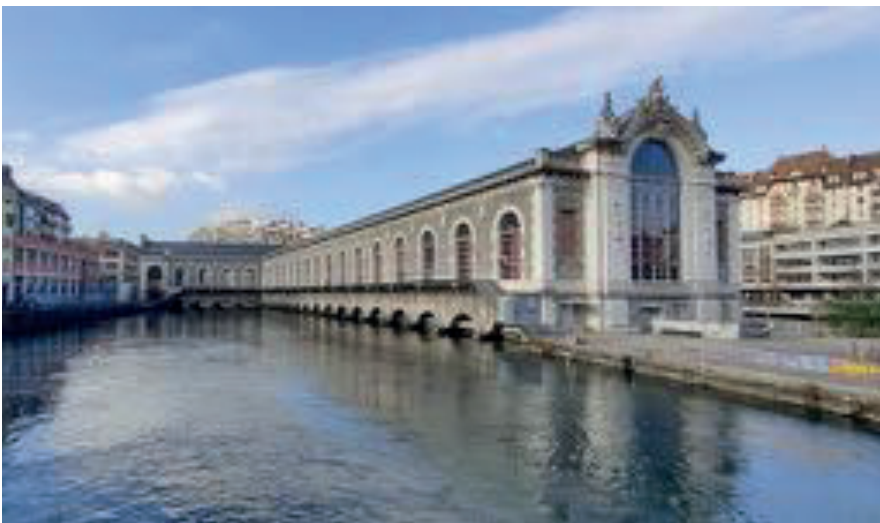
Figure 48. Bâtiment des forces motrices sur le Rhône
