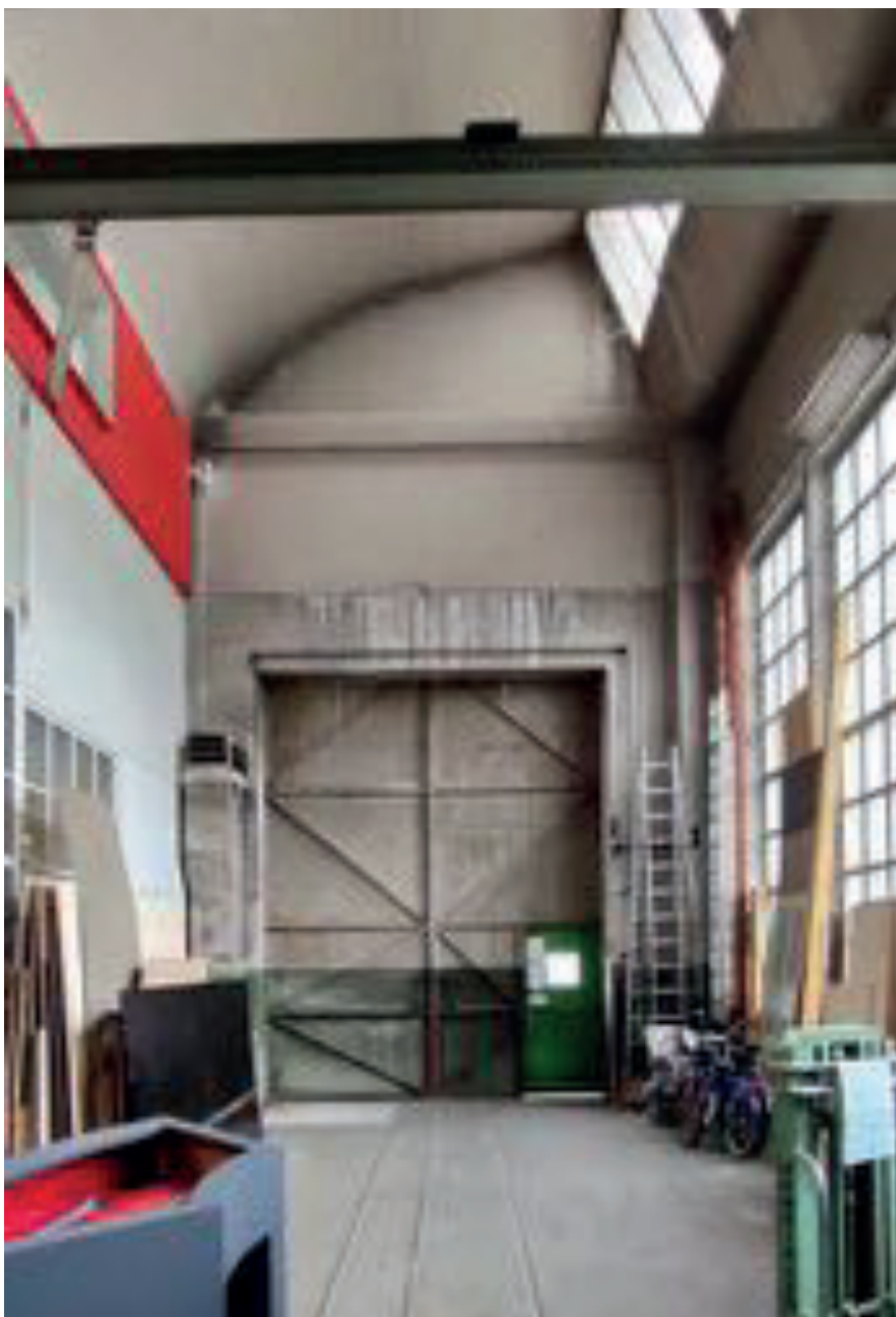
Figure 100. Des dégagements importants derrière les accès extérieurs
