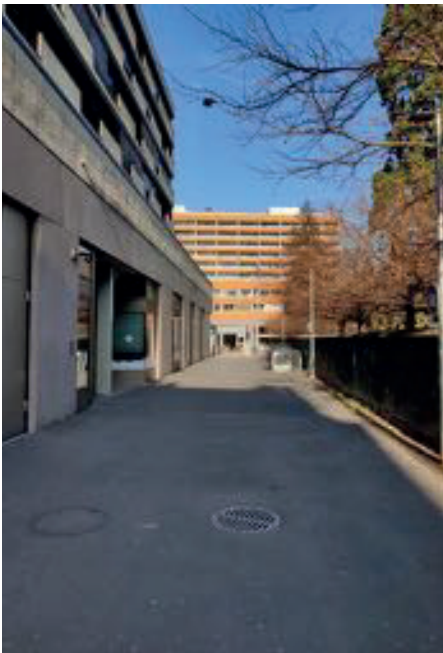
Figure 115. Un des accès à l'écoquartier qui longe le cimetière des Rois
