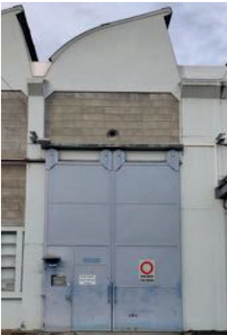
Figure 104. On retrouve le principe d'accès facilité dans le corps du bâtiment par de grandes portes
