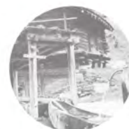
Structure en bois
