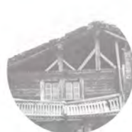
structure de toiture en bois
