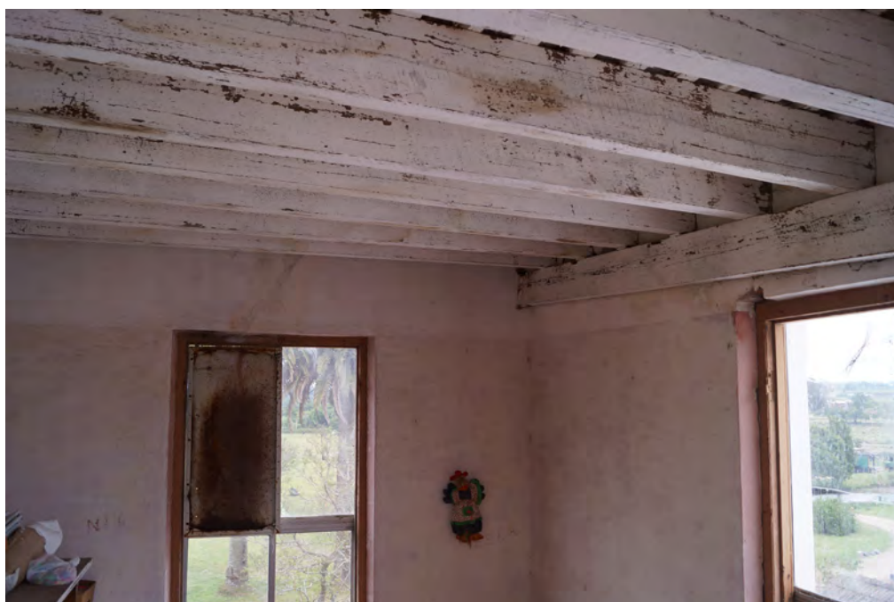
Figure 145 :Charpente de la Casona
