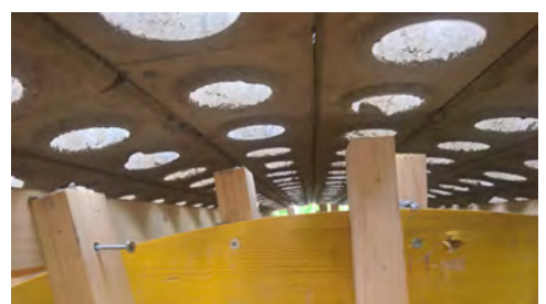
Figure 185 : Décoffrage de la voûte.
