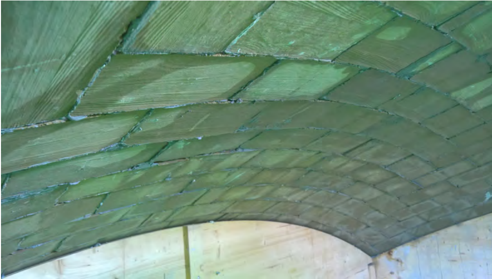
Figure 66: Détail de la voûte catalane avec les nervures du moule en bois imprimé sur la brique.
