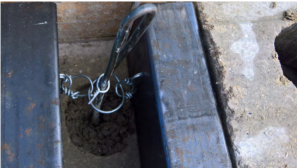
Figure 129 : Linteau métallique fixé à l'armature avec un fil de fer
