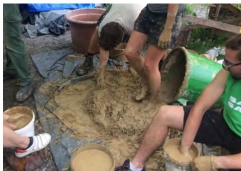
Figure 47 : Mélange de la terre viseuse avec la paille et malaxage à la main.
