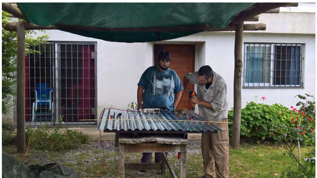
Figure 133 : Fixation de la tôle ondulée sur la charpente préfabriquée
