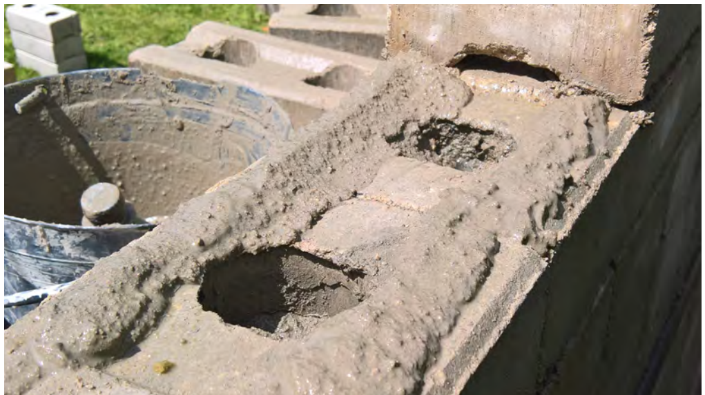
Figure 127 : Collage des briques avec un mortier de terre (même recette que les briques)
