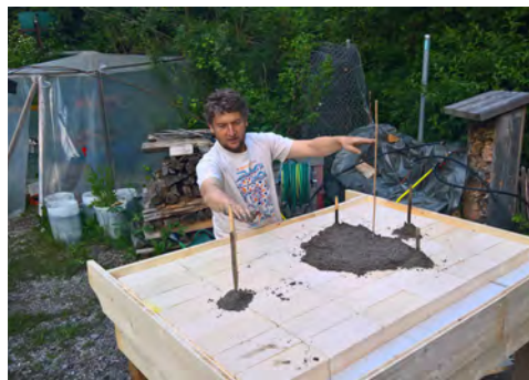
Figure 42 : Construciton du moule en sable
