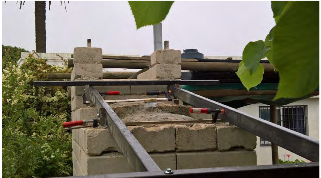
Figure 132 : Prémontage de la toiture métallique sur le grill
