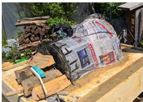
Figure 43 : moule en sable fini
