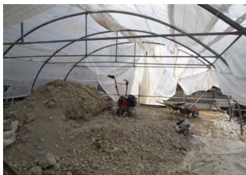
Figure 31 : Séchage de la terre pour les enduits sous un tunnel agricole.
