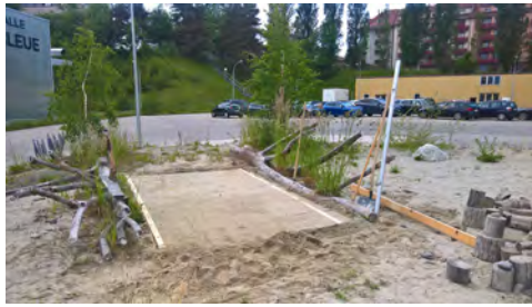
Figure 174 : Lit de sable nivelé.
