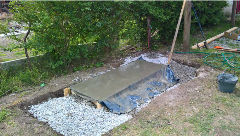
Figure 116 : Radier en béton armé
