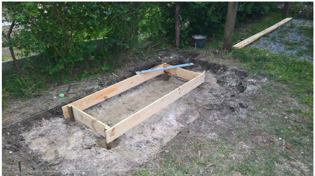
Figure 114 : Pose du coffrage
