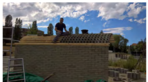
Figure 183 : Construction de la voûte.
