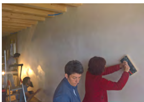
Figure 55 : Lissage du crépi de finition.
