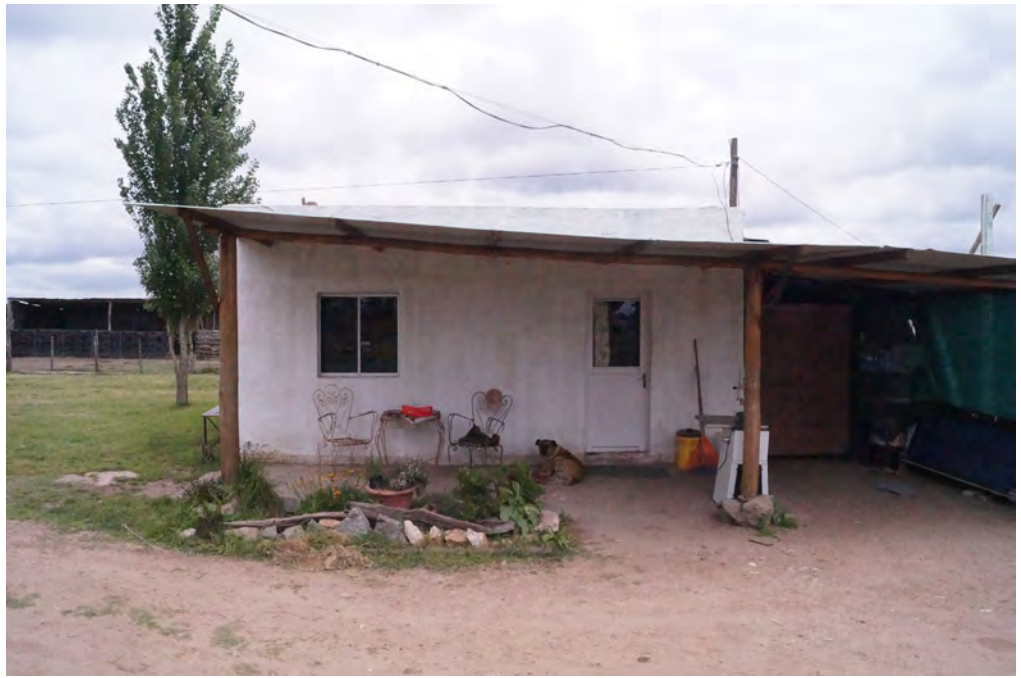
Figure 148 : Casa 1 façade est
