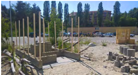
Figure 176 : Construction des murs avec latte de bois.
