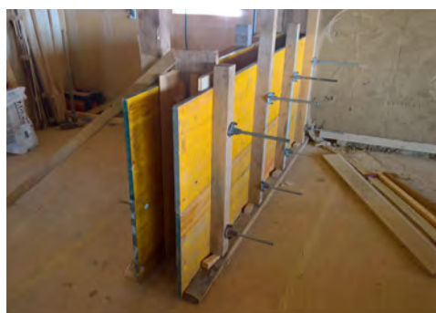
Figure 58 : Coffrage pour le banc
