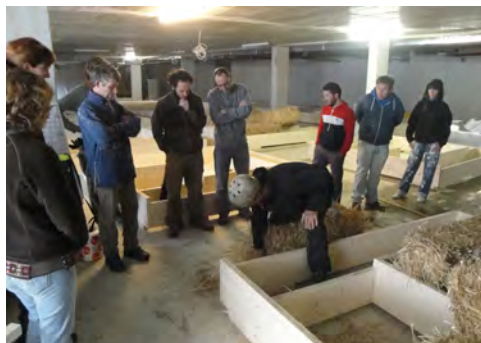
Figure 27 : Explication pour le remplissage des botte de paille dans le cadre
