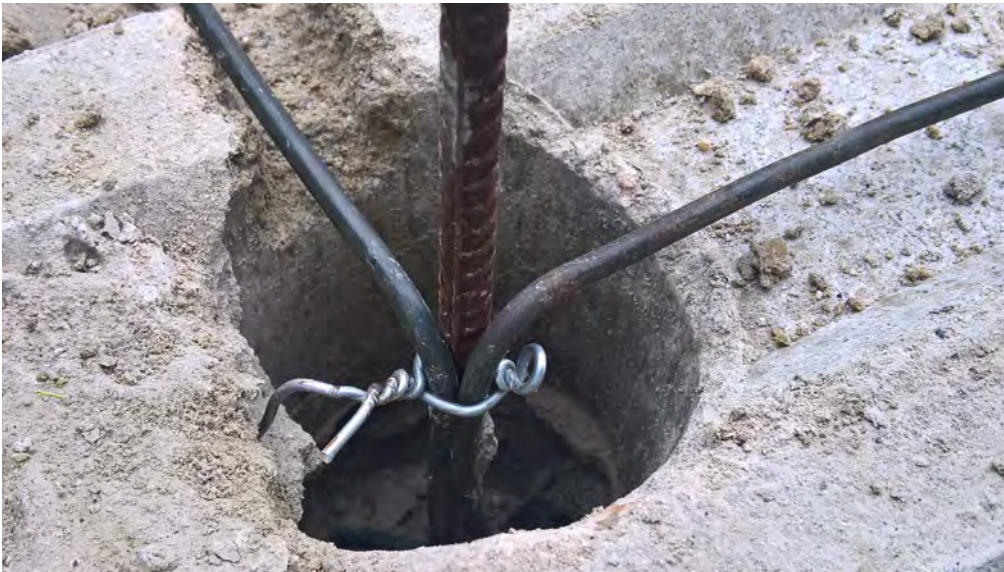
Figure 122 : Pose d'une armature horizontale à la hauteur de la table
