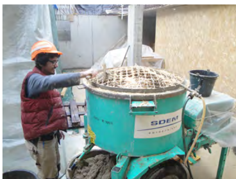
Figure 37 : Préparation de l'enduit en terre avec le malaxeur par Nicolas du collectif CARPE
