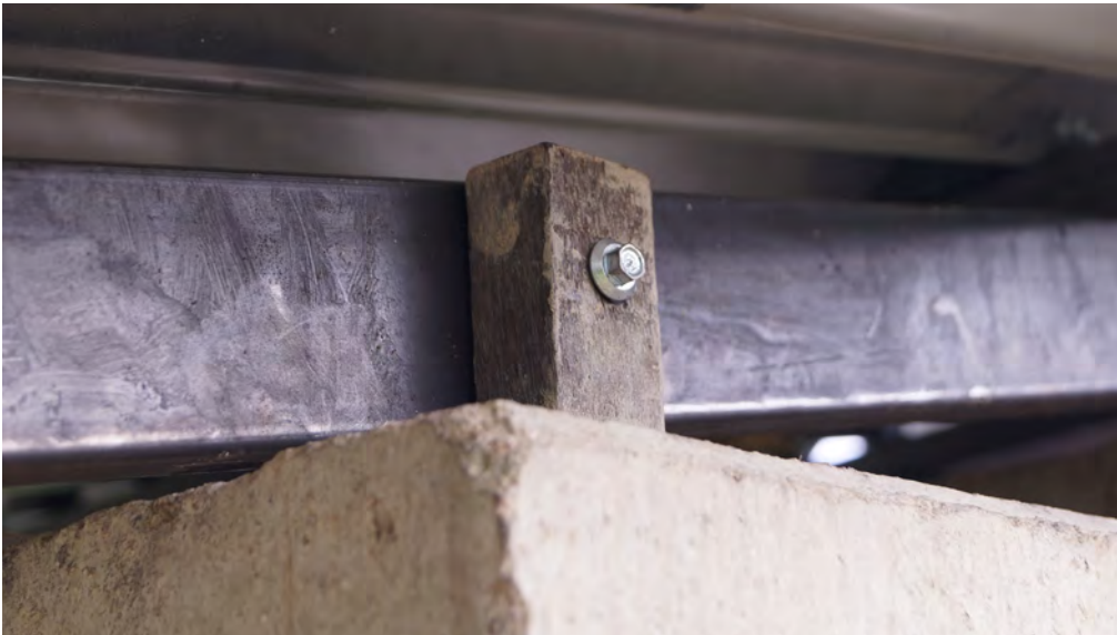
Figure 134 : Fixation de la toiture finie sur la latte en bois
