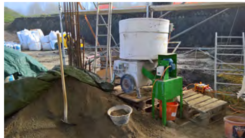
Figure 165 : Mélange de la terre et du ciment dans le malaxeur avant de concasser les mottes.
