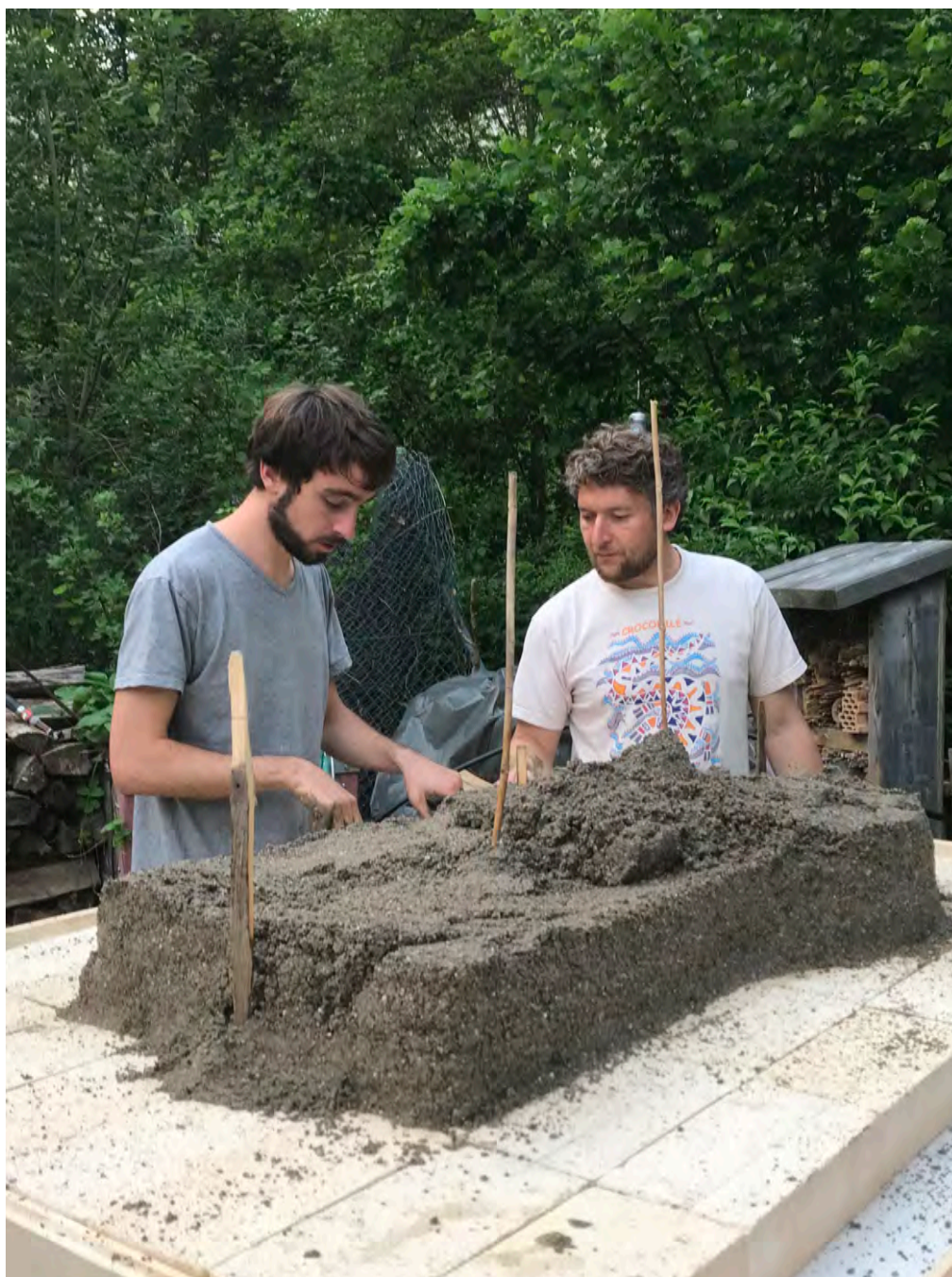
Figure 38 : Construction d'un moule en sable et passage de connaissance
