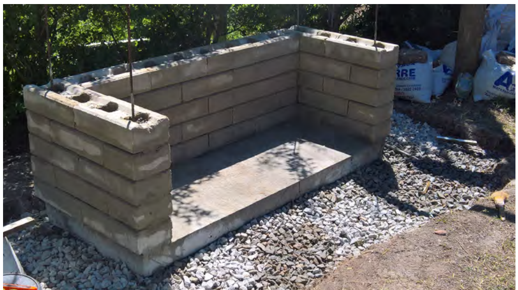
Figure 121 : Collage des lignes avec un mortier de terre
