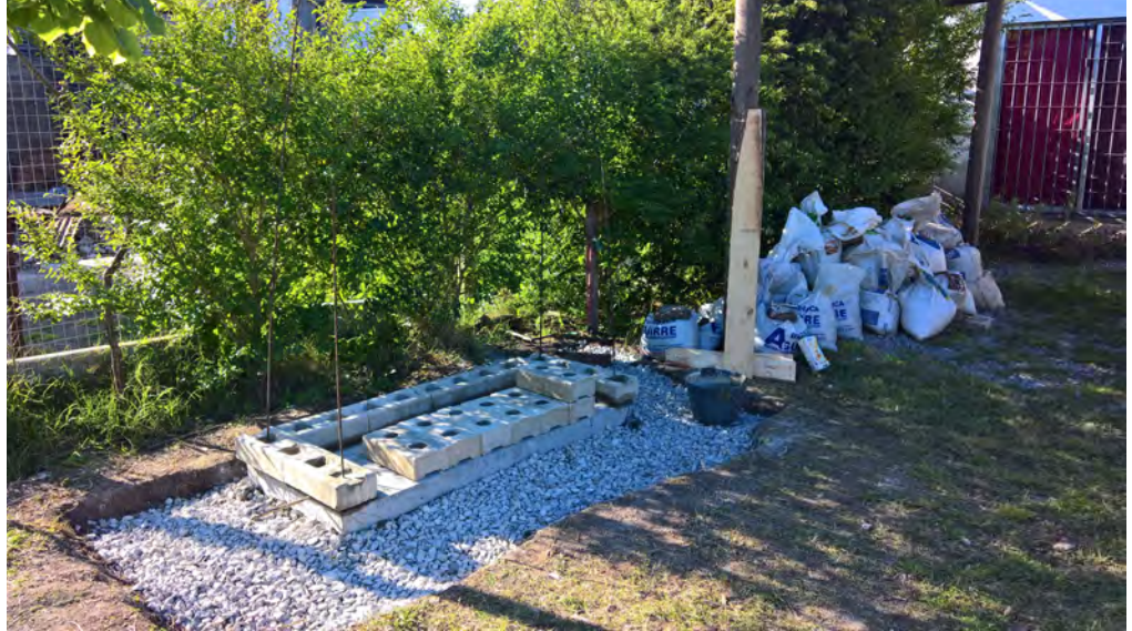
Figure 119 : Collage de la première ligne de brique avec un mortier hydrofugé
