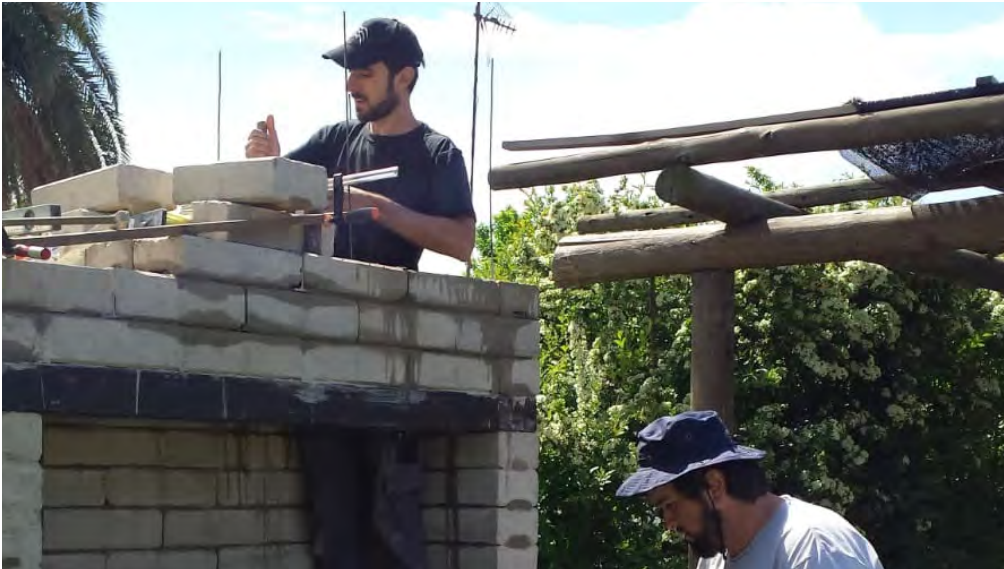
Figure 128 : Collage des lignes avec un mortier de terre
