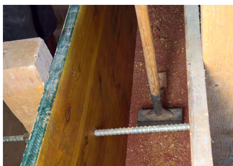
Figure 59 : Compression de la terre à l'aide à la dame.
