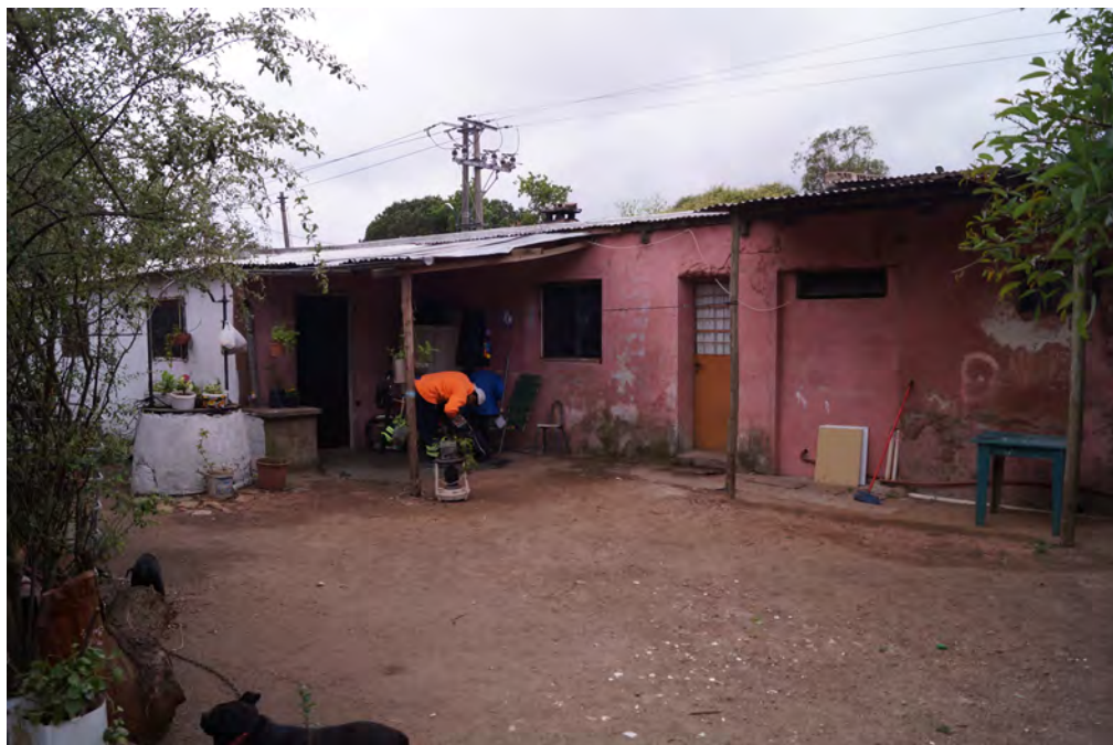
Figure 150 : Casa 2 façade est
