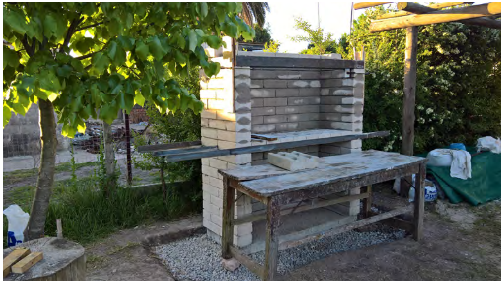
Figure 126 : Linteau métallique
