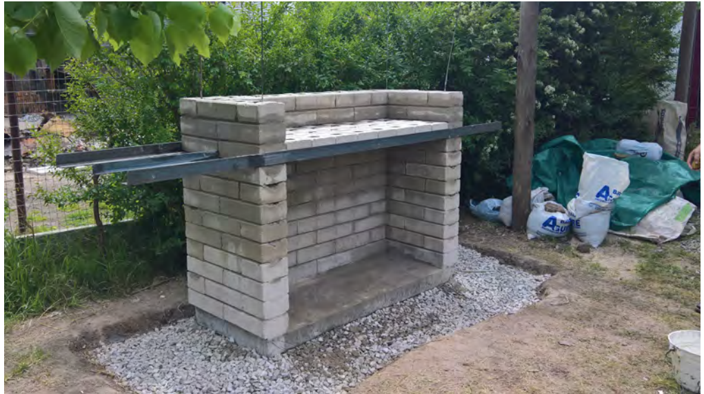
Figure 125 : Collage des lignes avec un mortier de terre
