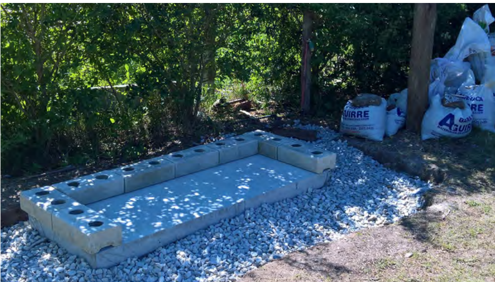
Figure 118 : Pose de la première rangée de ligne pour vérifier la dimension du radier
