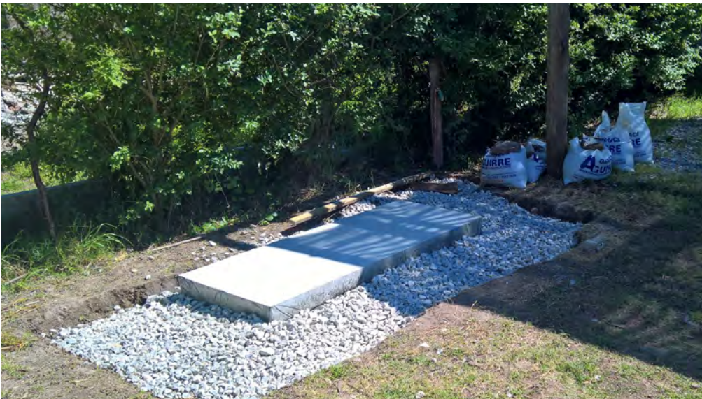
Figure 117 : Décoffrage du radier en béton
