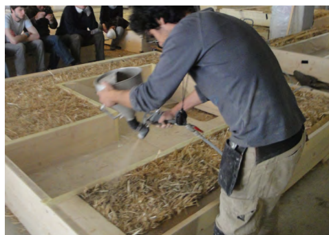
Figure 30 : Les supports et arrêt d'enduit mis en place, on met un fond d'accrochage à base de barbotine
