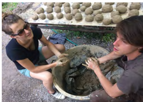
Figure 45 : Préparation du COB sous forme de boules
