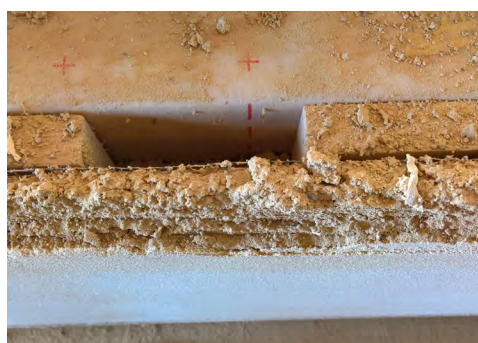
Figure 56 : Détail des différentes couches de l'enduit.
