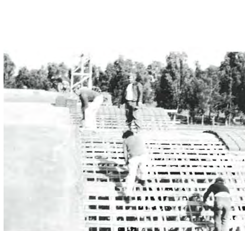
Figure 84: Voûte en construction
