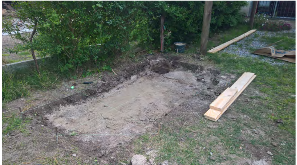
Figure 113 : Décapage de la terre végétale
