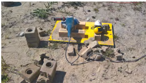
Figure 178 : Coupe des 1/2 briques.
