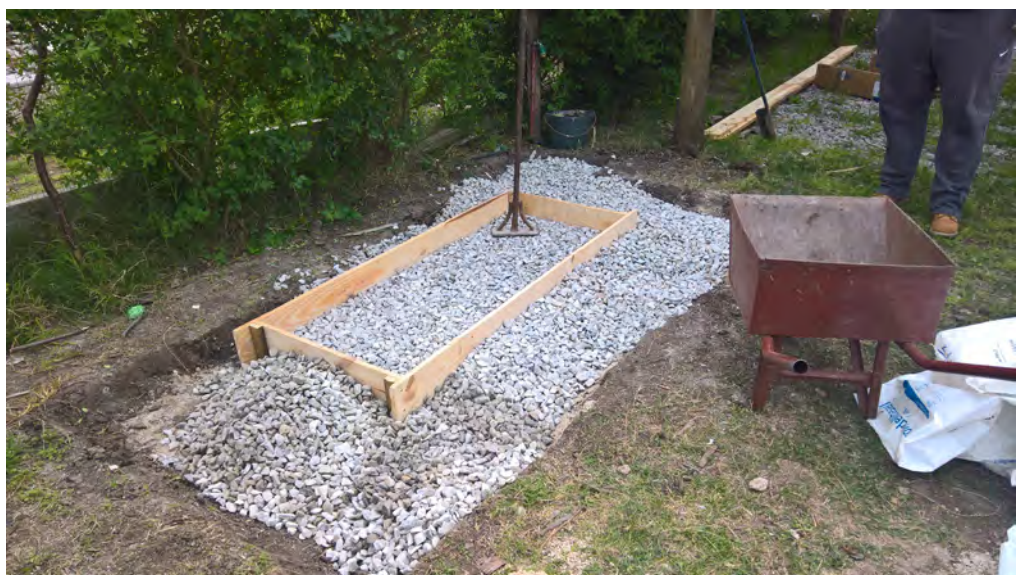
Figure 115 : Pose d'un lit de hérisson
