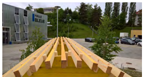
Figure 181 : Coffrage fini .
