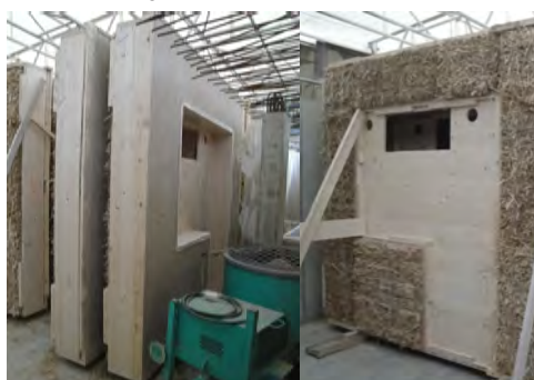
Figure 35 : Les éléments de façade secs sont stockés à la verticale avant sa mise en place
