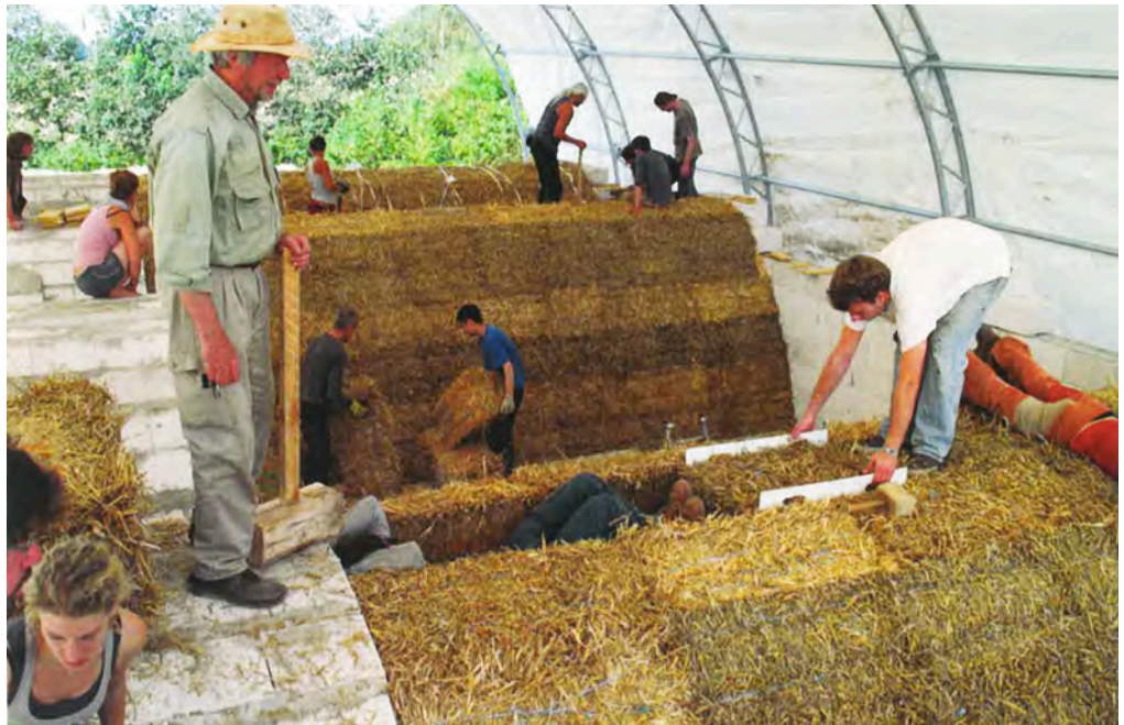
Figure 203 : Construction de voûtes en paille pour cinq unités d'habitation, Buchberg-Wangelin Allemagne, 2013
