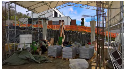
Figure 167 : Curage des briques.
