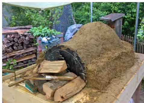
Figure 48 : Montage lu deuxième dome sur le premier. frais sur frais
