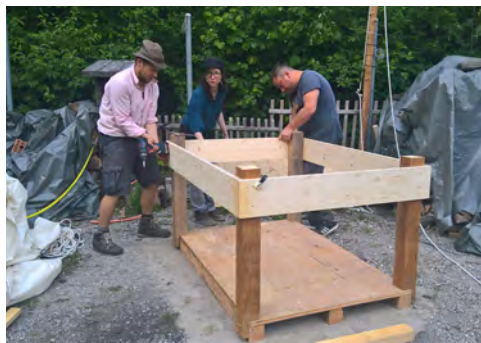
Figure 41 : Construciton de la table à feu
