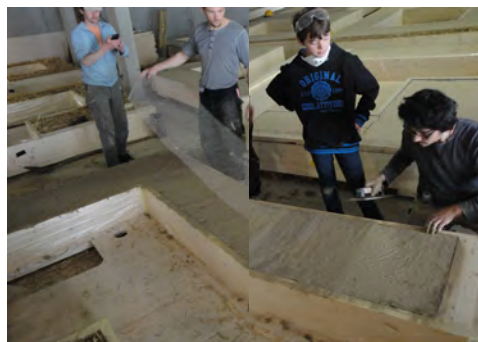
Figure 34 : mise en place de filet en lin pour reprendre les fissures du au séchage de la terre
