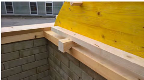
Figure 180 : Coffrage sur coin pour le démontage.
