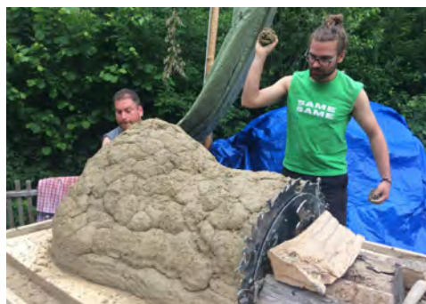
Figure 46 : Les boules sont lancées sur le moule avant d'être lissée.
