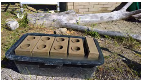
Figure 182 : Briques dans l'eau avant de les coller.
