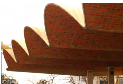
Figure 82 : Terminal de bus, Arq. Néstor J. Minutti, Ing. Eladio Dieste 1973, Salto UY
