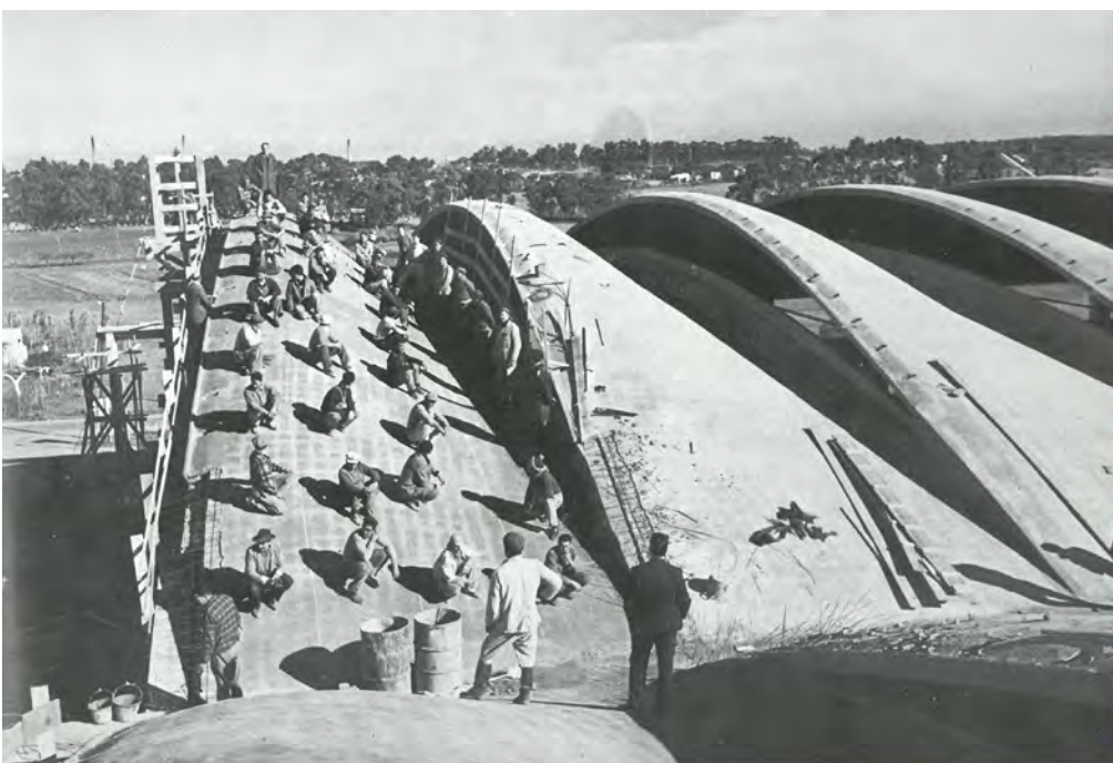
Figure 85 : Essais de charge, Porto Alegre
