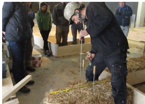
Figure 28 : Bottelage de botte de paille à la bonne longueur à l'aide d'un jeu d'aiguille
