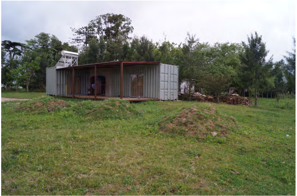
Figure 154 : Casa 4, angle sud ouest
