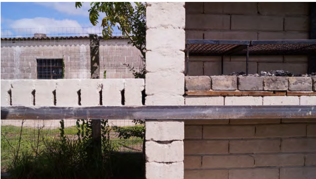
Figure 135 : Appeillage de briques
