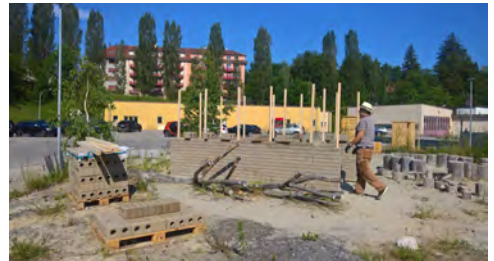
Figure 177 : Construction des murs avec lattes de bois.
