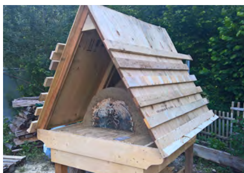
Figure 49 : Chapeau du fours avant de recevoir les tavillons
