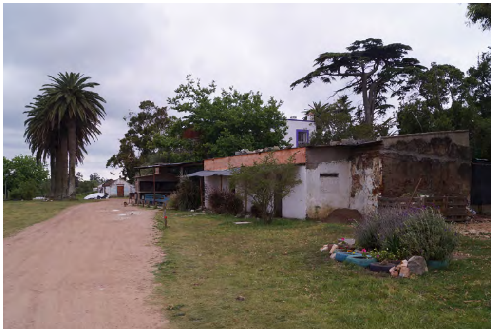
Figure 146 : Angle sud-ouest de la salle polyvalente
