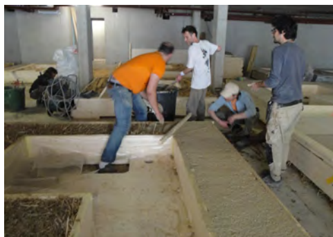
Figure 33 : mise en place de l'enduit en terre avec l'aide d'une règle
