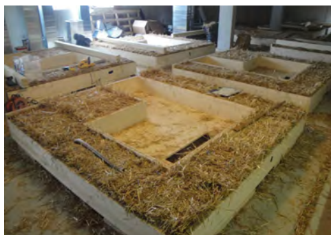
Figure 29 : Cadre remplis d'isolant
