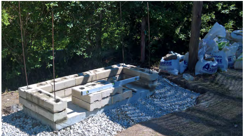
Figure 120 : Collage des prochaines lignes avec un mortier de terre
