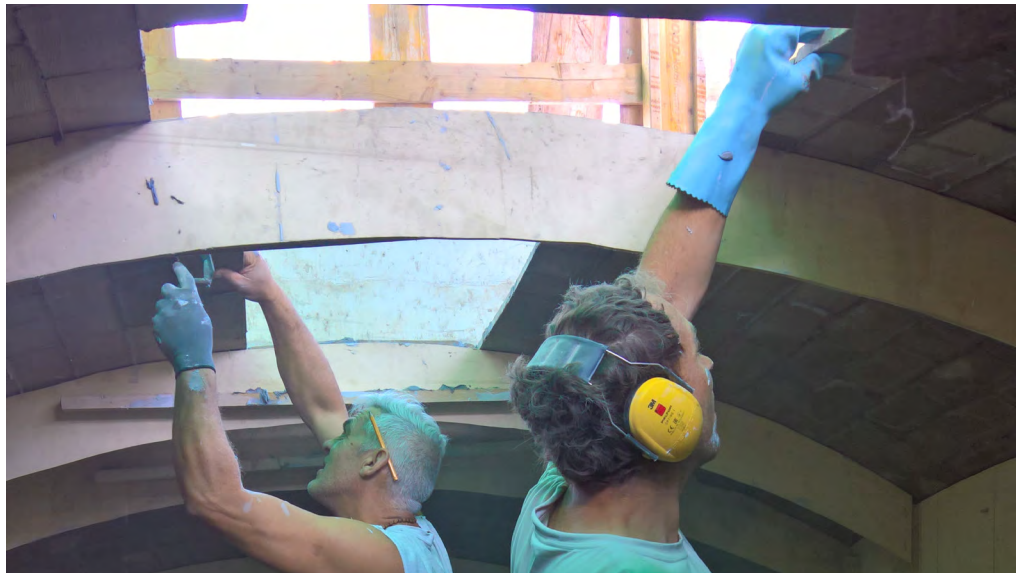
Figure 62 : Pose de la première couche de briques
