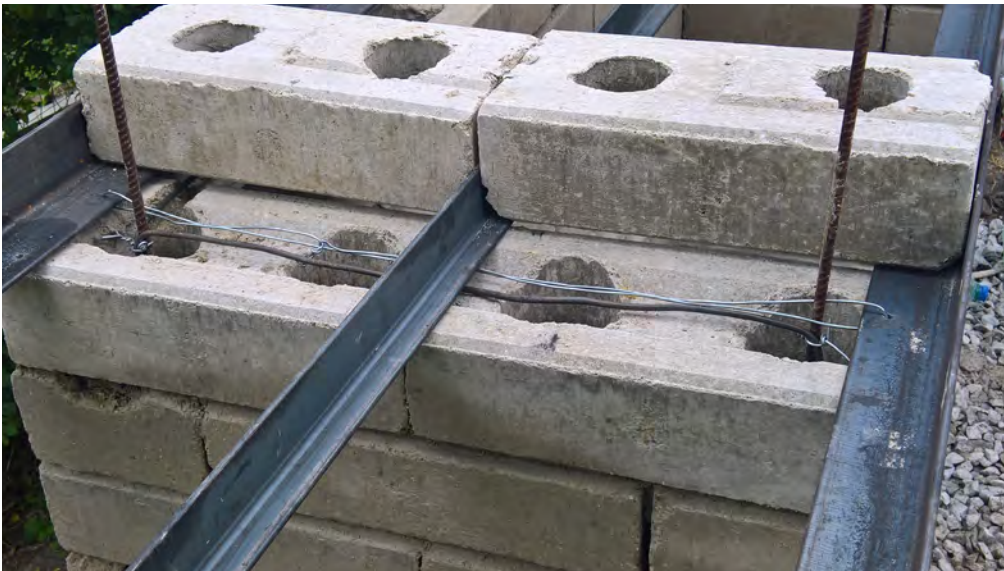
Figure 123 : Les équerres métalliques sont fixées à l'aide de fil de fer
