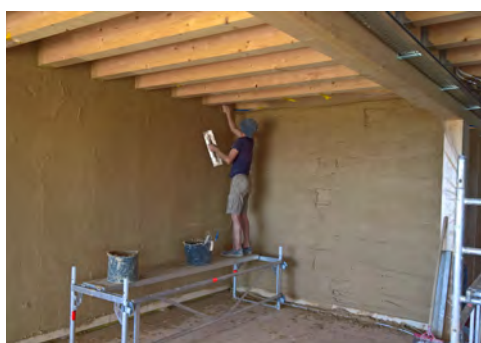
Figure 53 : Lissage du crépi fraîchement projeté.
