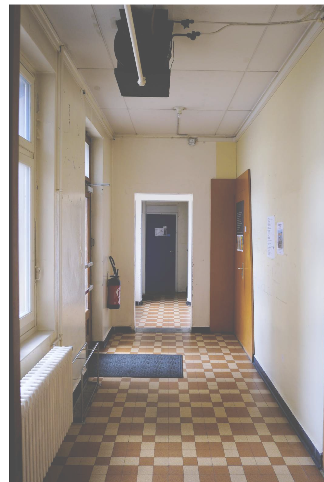
ESPACE SOUS LES COMBLES
